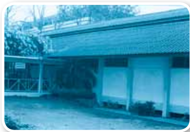
อาคารปฏิบัติการกายภาพบำบัด ก่อสร้างปี พ.ศ. 2532
