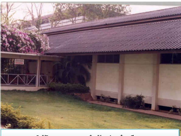
อาคารปฏิบัติการกายภาพบำบัด ก่อสร้างปี พ.ศ. 2532
